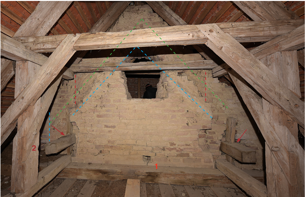
Abb. 9: Langhaus, Dachraum, Blick Richtung Osten
