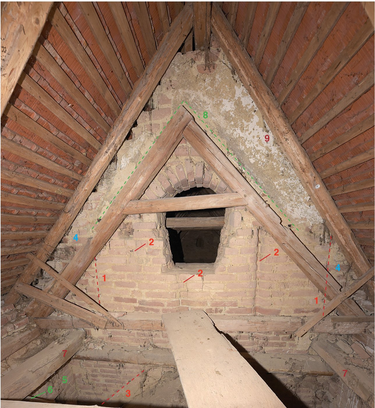
Abb. 11: Chor, Dachraum, Blick Richtung Westen
