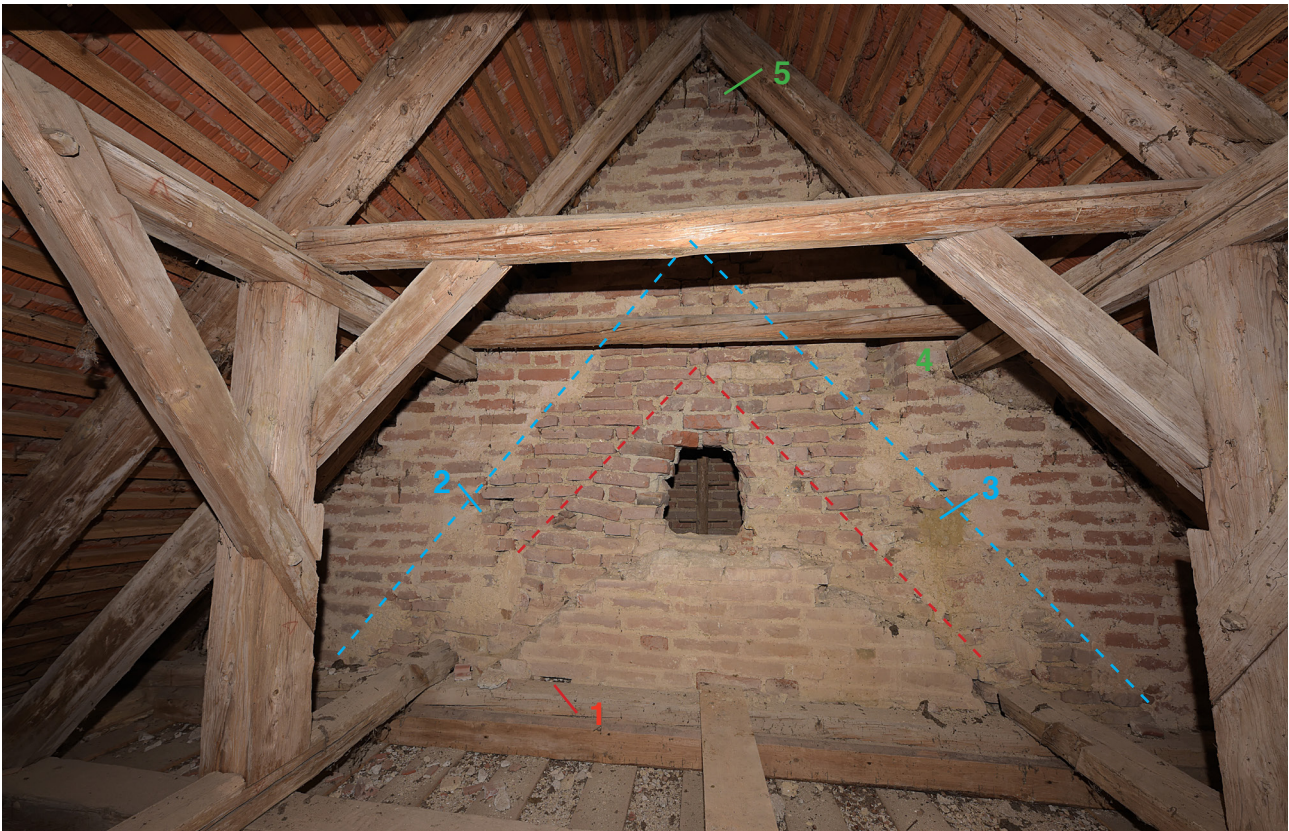
Abb. 10: Langhaus, Dachraum, Blick Richtung Westen
