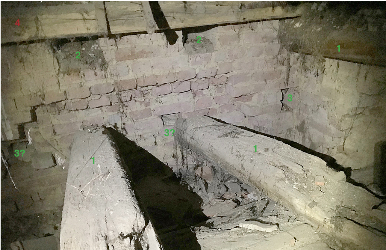
Abb. 12: Chor, Dachraum, Blick Richtung Nordosten
