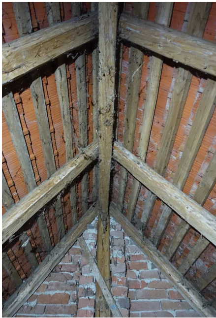
Abb. 17: Zweitverwendeter Firstständer an der Ostgiebelwand.
