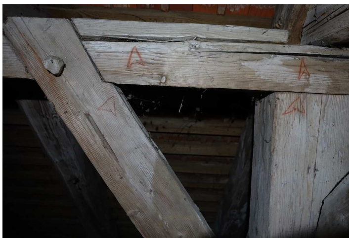
Abb. 9: Zusammengehörige Röte-Symbole am südlichen Stuhl im 1. Binder von West; der Anschluss des Längsbandes mit Holz nagel wirkt ursprünglich.
