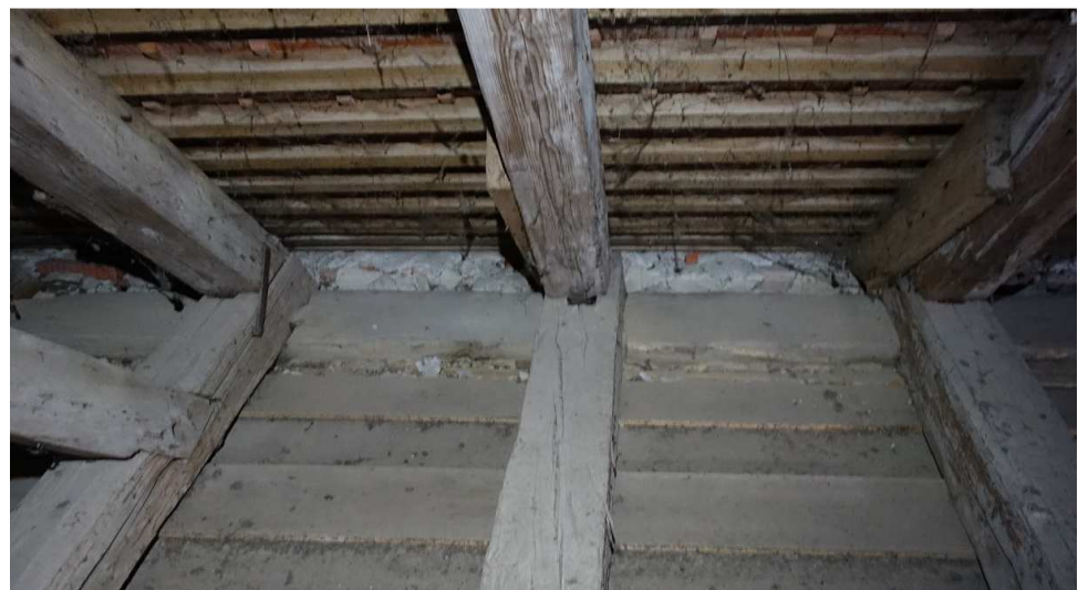
Abb. 3: Sparren auf der Dach-Südseite mit Fußpunkten; li. in den Zerrbalken eingezapftes Steigband des Stuhls.
