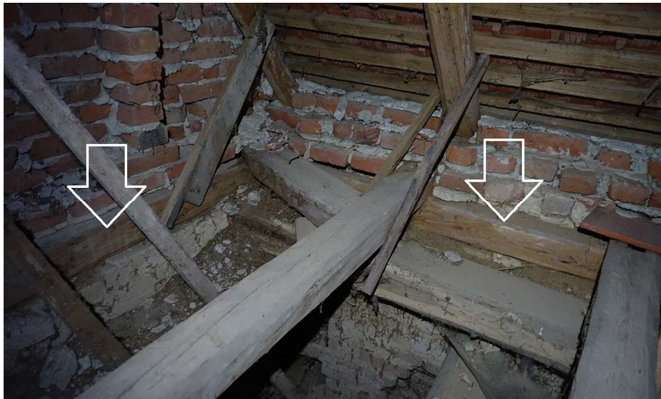
Abb. 14: Dreiseitiger Kranz aus Mauerschwellen (weiße Pfeile), darauf die Zerrbalken aufgekämmt; am linken schräger Stichbalken in die Südost-Ecke mit Zapfenloch.
