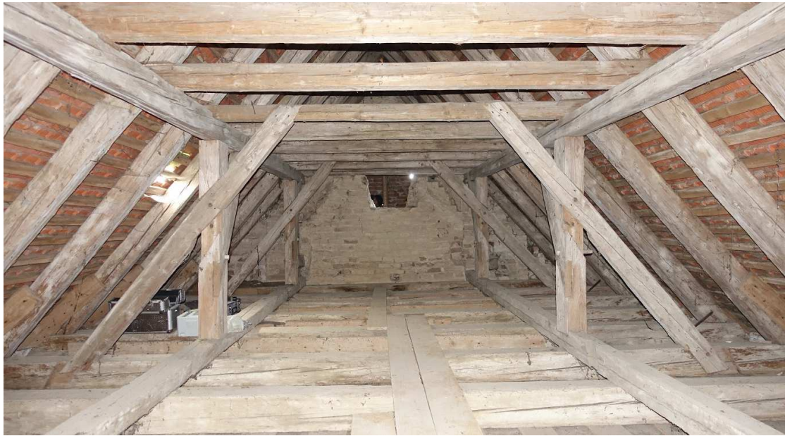
Abb. 2: Dachraum über dem Langhaus; Blick nach Osten zum Chor.
