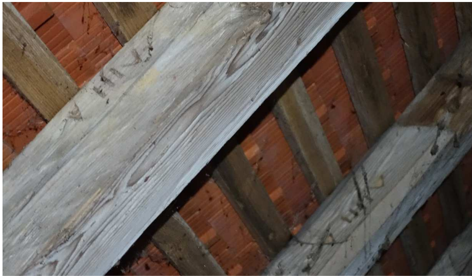
Abb. 8: Kurze eingestemte Bundzeichen an den Sparren der Dach-Nordseite (,VIII' u. ,VIII').
