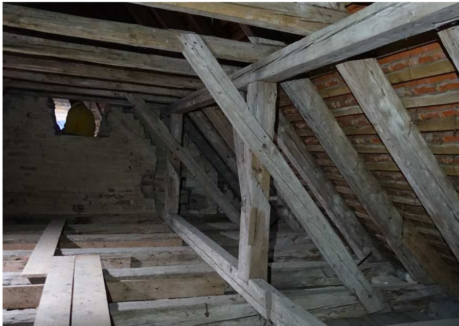
Abb. 6: Stehender Stuhl auf der Dach-Südseite: das Steigband in Binderachse sitzt in korrigierten Sassen.
