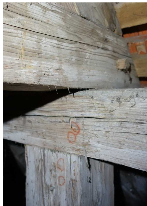
Abb. 9: Zusammengehörige Röte-Symbole am südlichen Stuhl im 1. Binder von West; der Anschluss des Längsbandes mit Holz nagel wirkt ursprünglich.
