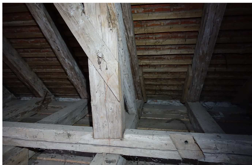
Abb. 7: Längs-Kopfband an der südlichen Stuhlreihe im Gespärre 6 von West, mit leerer Sasse an der Stuhlschwelle als Hinweis, dass es sich ursprünglich um ein Steigband gehandelt hat (Flucht versetzt).
