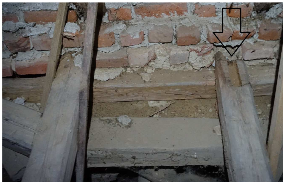
Abb. 15: Die beiden (ehemaligen) Zerrbalken im Osten: der westliche mit Zapfenloch an seinem südlichen Ende (Pfeil), der östliche ohne, aber mit schrägem Stichbalken.
