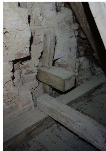
Abb. 13: Holzschloss am Ankerbalken-Süd vor Ostgiebel/ Langhaus.
