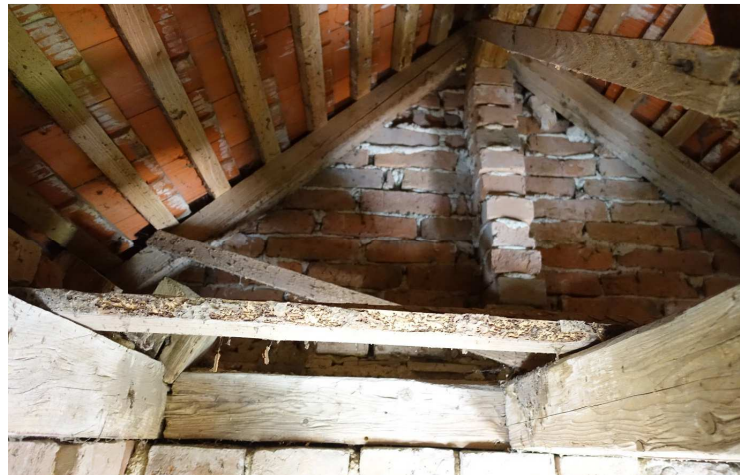
Abb. 20: Balkenkranz aus gebeilten Nadelhölzern mit Mittelteiler (re. unten); die gesägte Firstpfette auf einem Mauerpfeiler (hinten).
